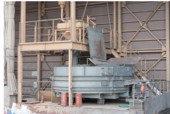
セメント固形化施設
