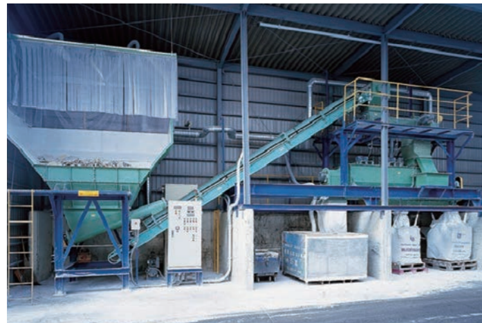
石膏ボード破碎・選別施設
